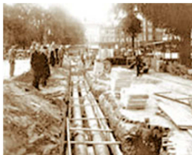
Figuur 2: aanleg warmtenetwerk in Utrecht
